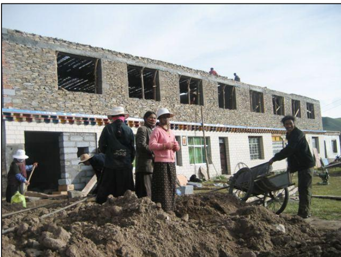
Spital Kashi – Auch Frauen helfen beim Bau des oberen Stockwerkes
